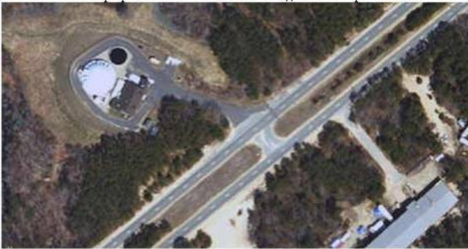
Рис. 4. Аэрофотоснимок с сайта MassGIS после завершения строительства.
