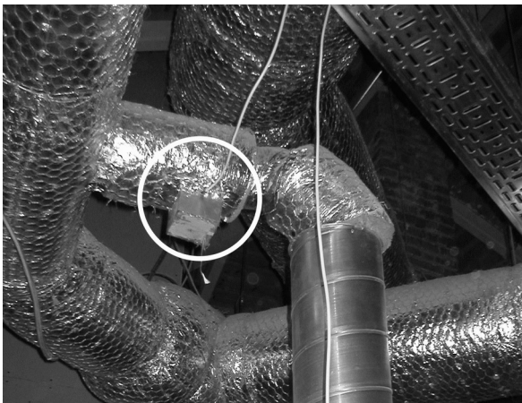
Рисунок 8 – Размещение акустического излучателя вне воздуховода
