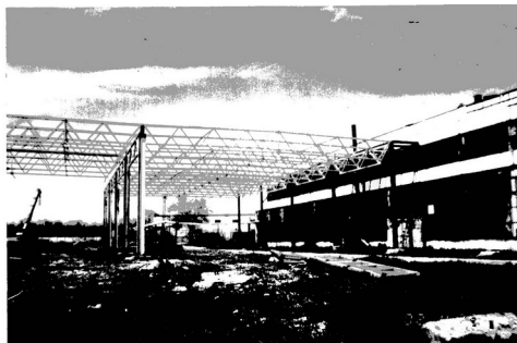
Рис. 4. Общий вид стальных ферм покрытия из замкнутых гнутосварных профилей типа «Молодечно».
