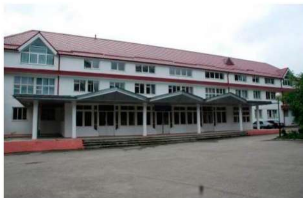
Корпус по адресу: по ул. Украинская, 56а
