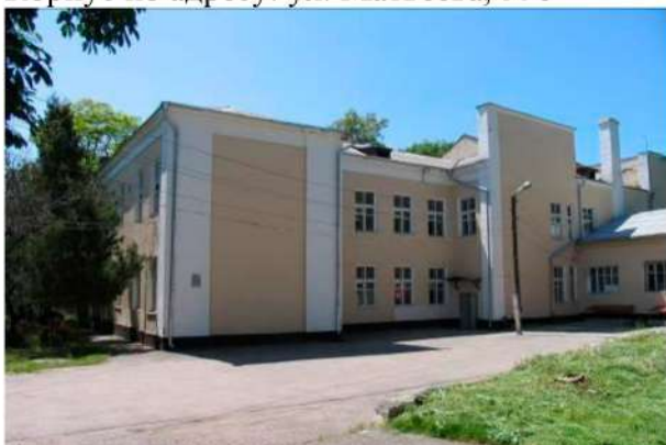
Корпус по адресу: ул. Московская, 31
