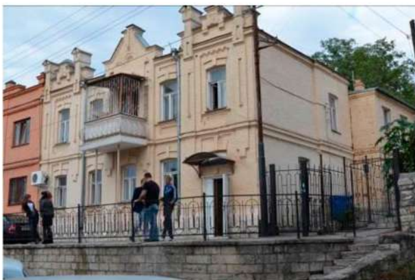
Корпус по адресу: ул. Гоголя, 2/4
