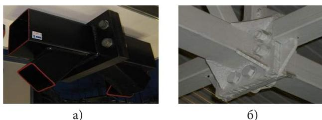
Рис. 6. Общий вид монтажных стыков фермы:
