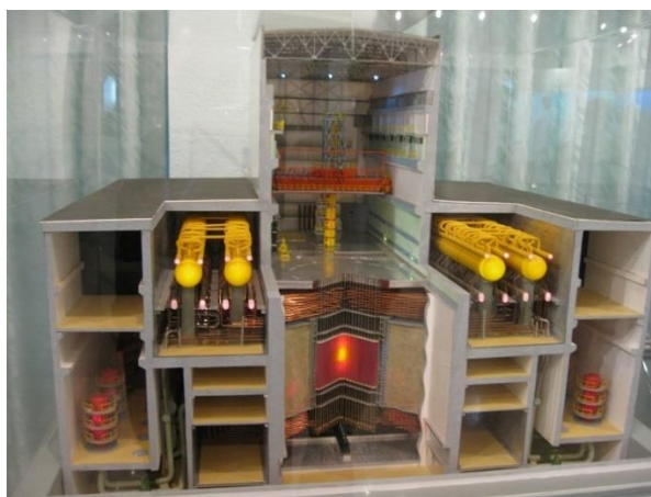
Рисунок. 1. Устройство РБМК-1000 / Figure 1. RBMK-1000 device
