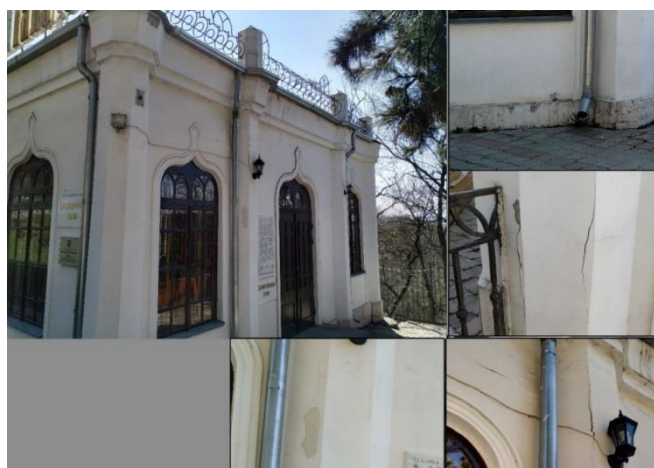
Рисунок 5. Дефекты конструктивных элементов галереи Михайловской
