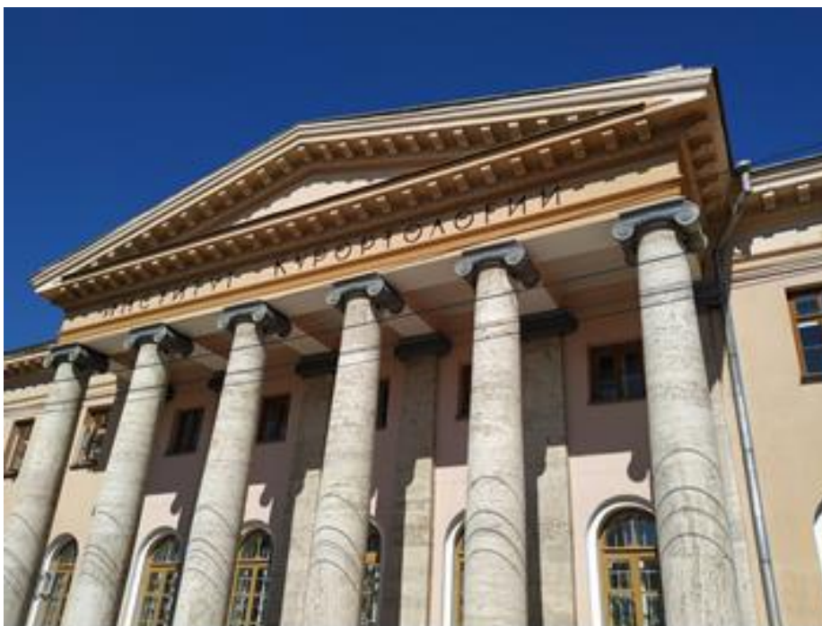
Рисунок 10. Внешний вид здания «Ресторации»
