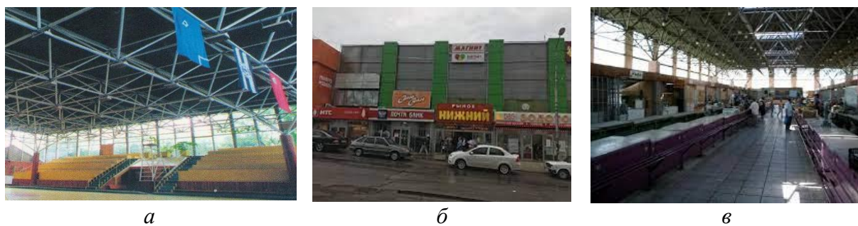
Рисунок 1. Снимки спортивного зала в Кисловодске (а) и Нижнего рынка в Пятигорске (б, в) / Fig. 1. Photos of the gym in Kislovodsk (a) and Nizhny market in Pyatigorsk (b, c)
