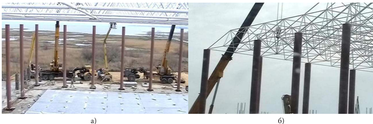
Рис. 3. Облегченное пространственно-стержневое покрытие в процессе монтажа: а – вид изнутри; б – вид снаружи
