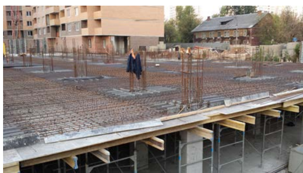
Рис. 2. Перекрытие перед бетонированием
