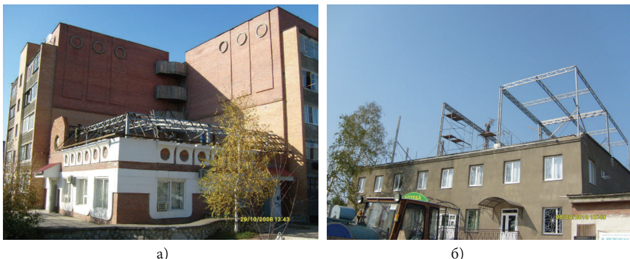
Рис. 6. Общие виды реконструкции одноэтажного здания с ГВЭ из четырех блоков покрытия типа «Пятигорск» с размерами в плане 5 \times 5 м (а) и реконструкции двухэтажного здания с ГВЭ из восьми блоков покрытия типа «Пятигорск» с размерами в плане 6 \times 6 м (б)
