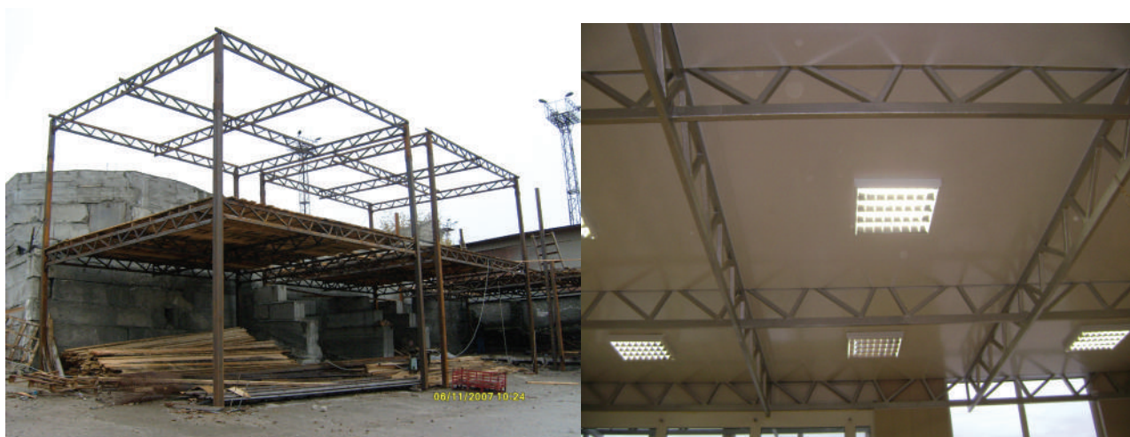
Рис. 4. Снимки двухэтажных модулей при возведении складского строения (а) и блока перекрытия в интерьере офисного здания (б)
