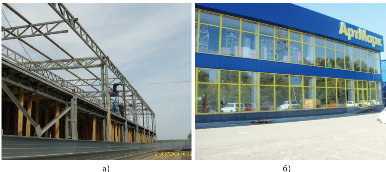
Рис. 7. Общий вид здания торгового предприятия с первым этажом из восьми блоков перекрытия типа «Пятигорск» размерами в плане 6 \times 6 м, а также ГВЭ из четырех блоков покрытия типа «Пятигорск» размерами в плане 12 \times 12 м в процессе строительства (а) и эксплуатации (б)
