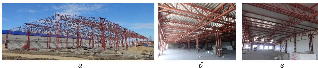
Рисунок 2. Снимки общего вида нового строительства (а), а также модулей 7×7 м его перекрытия (б) и модулей 14×14 м покрытия (в)
