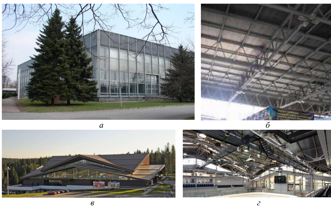
Рисунок 1. Снимки павильона «Механизация сельского хозяйства» в Киеве (а) и ортогональной системы перекрестных ферм стальных из парных уголков его покрытия (б), а также ледовой арены в 50 км от Санкт-Петербурга (в) и ортогональной системы перекрестных стальных ферм из прямоугольных труб ее покрытия (г)
