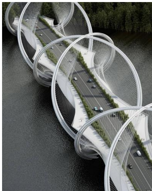
Рис.6 Мост San Shan в Пекине (Китай)
