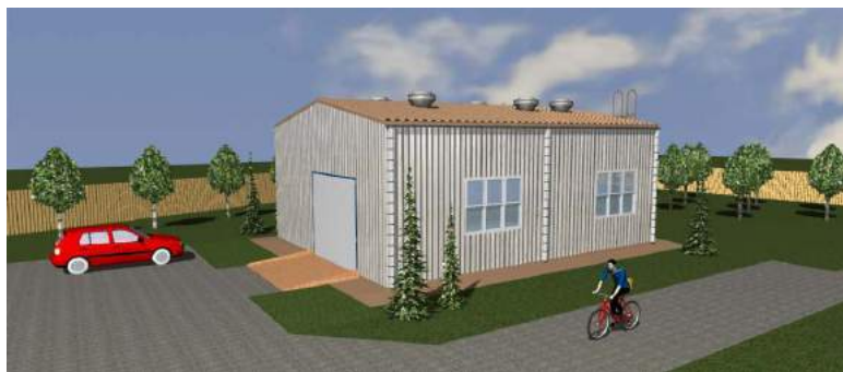
Рис. 9. Современное здание насосной станции каркасного типа размером в плане 12 x 9 м
