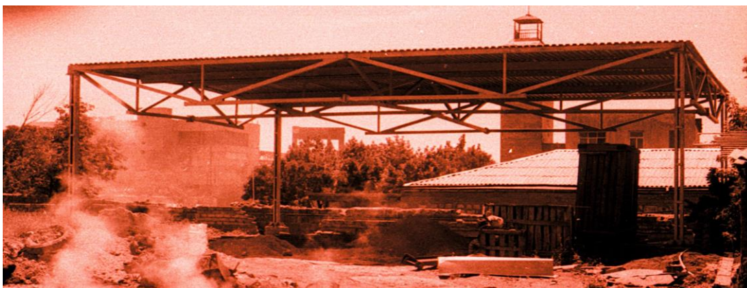
Рис. 3. Схема опытно-промышленного образца блока покрытия (а); расчетное сечение его ферм (б); общий вид натурального испытания (в); общий вид модуля после монтажа для постоянной эксплуатации (г): 1 – контурные фермы; 2 – внутренние фермы; 3 – прогоны; 4 – профилированный настил; 5 – колонны
